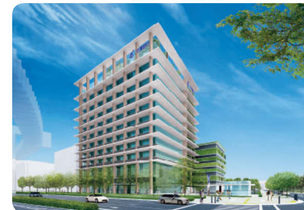
平成27年2月竣工予定
