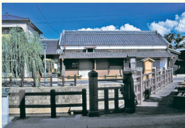
伊能家旧宅 店舗部分で奥に書院が続いています
