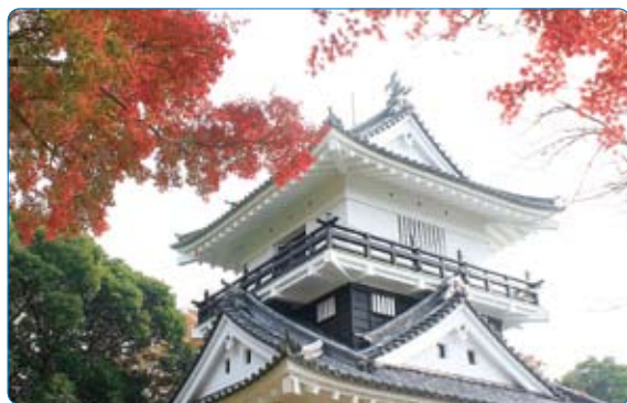
▲天守閣は鉄筋コンクリートの2層3階建てです
