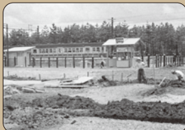
工事中の八千代台駅前 (昭和31年頃)
