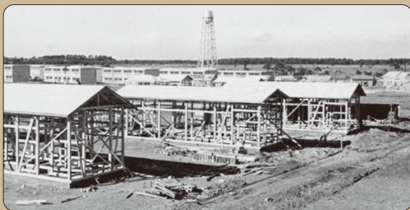
建設中の住宅(昭和30年頃)
