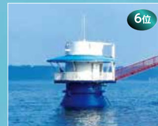
串本海中公園 海中展望塔 和歌山県東牟婁郡串本町 高さ14.0m 設置水深7.8m 営業開始 1970(昭和45)年
